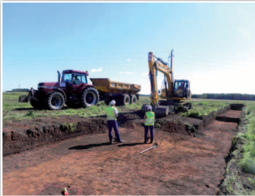
▲ figure 20 Première phase de décapage.
