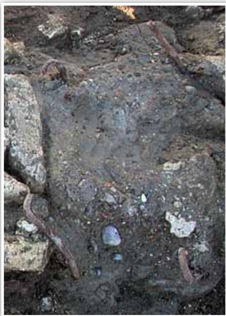
FIGURE 25 Zone 1/2. Élément du mur M 101. Unité de construction USC 1116 (béton, fers à béton). Vu depuis le sud.
